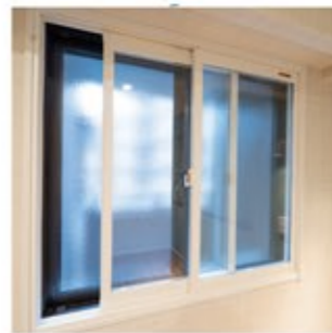
湿気がこもり易く、結露していた北側窓には内窓を設置。
