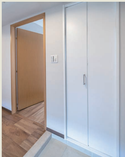
① クローゼットの壁に折れ戸を取付
