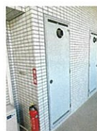
1. バイパススペース全体
